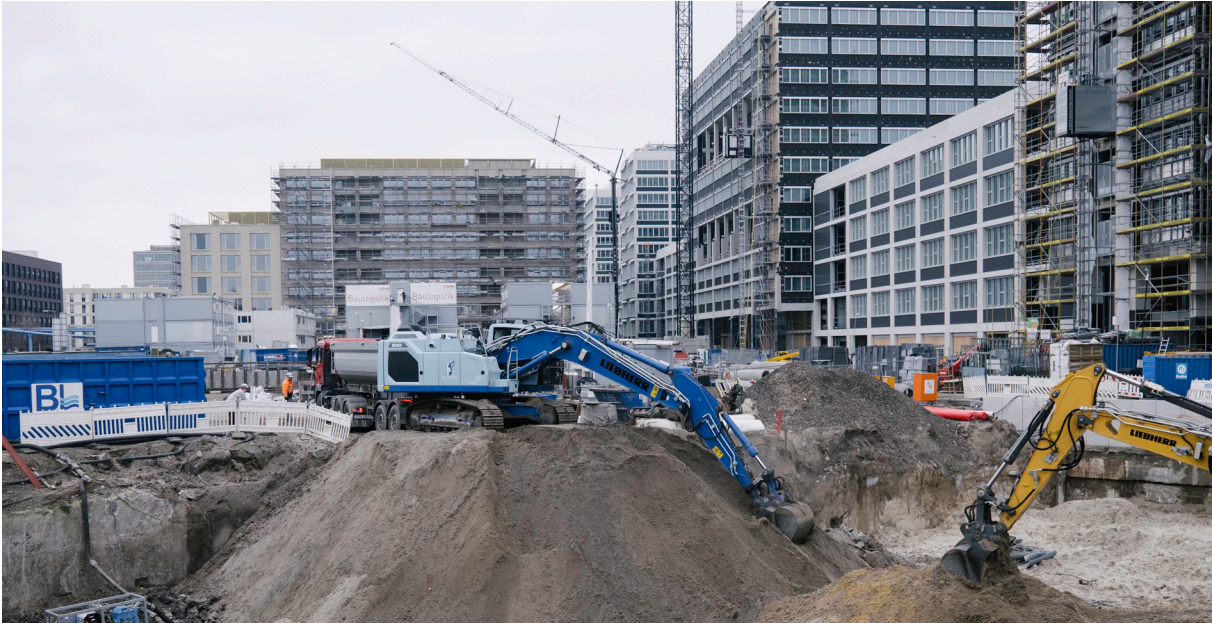
Abbildung 1: Baustelle in Berlin-Mitte - aus Abfall wird Ressource. Alle Abbildungen im Pressekit.
